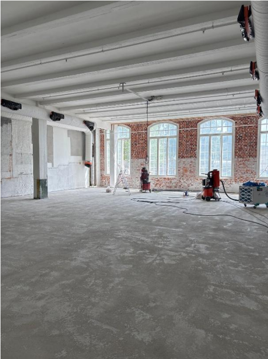
126 tilan tiilipinnan esiinottaminen → Exposure of the brickwork in Room 126
